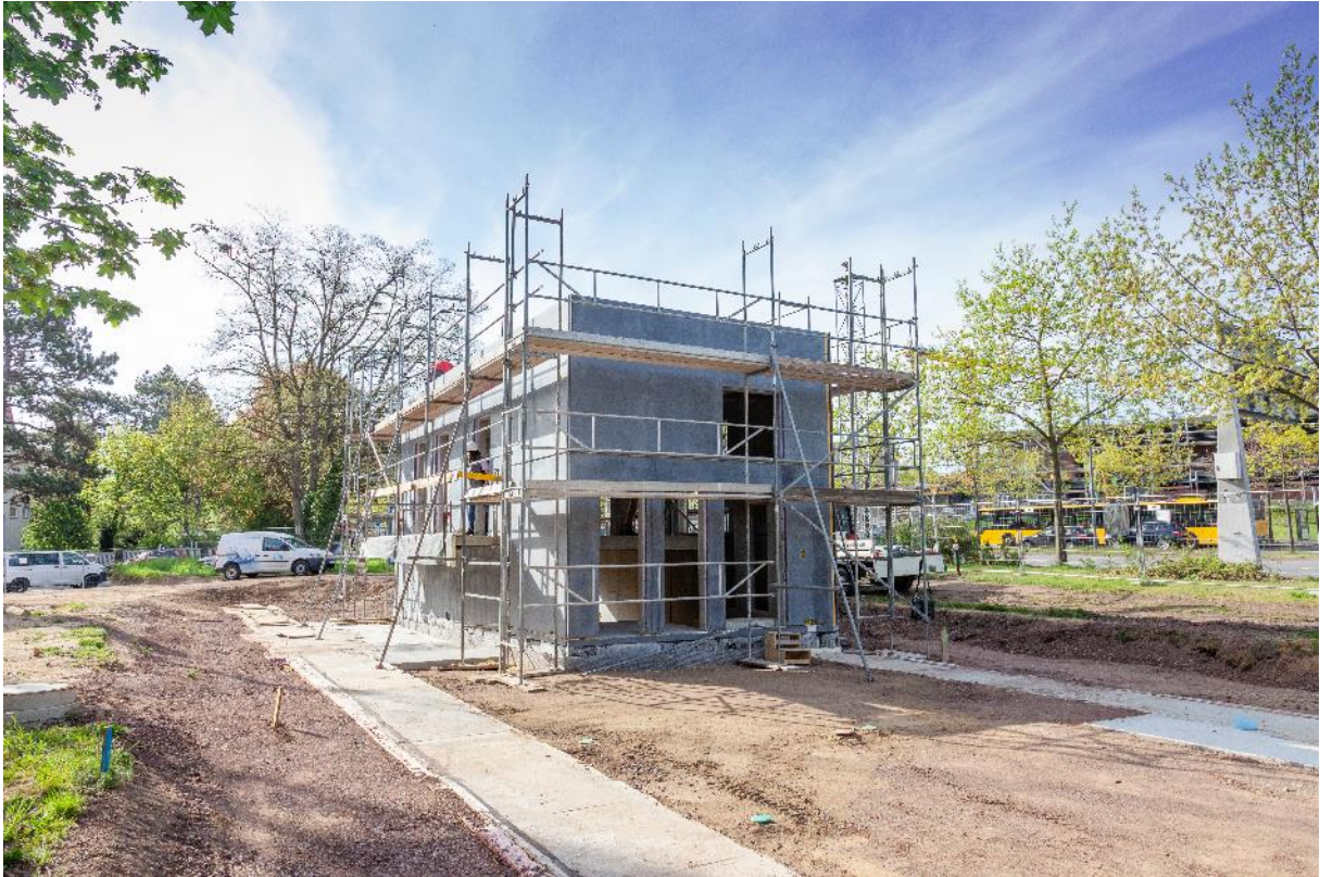
4: Die BOX steht nun, die Vorbereitungen für den nächsten Bauabschnitt starten Ende Mai. © Stefan Gröschel, IMB, TU Dresden
