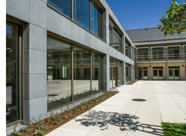
GEBIZ in Albstadt: kleinformrige hinterlüftete Vorhangfassade mit solidian-Bewehrung Quelle: solidian
