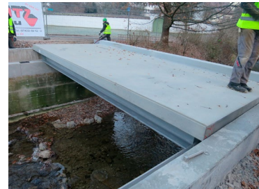
Ersatzneubau – Einbau der neuen Fahrfläche aus solidian-Carbonbeton in Albstadt-Margrethausen.
