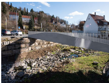
Die 15 m lange Brücke in Albstadt ist ausschließlich aus Carbonbeton hergestellt.
