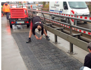
Reparaturen einer Brückenkappe mit solidian-Carbonbeton.
