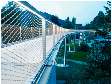
Längste textilbewehrte Fußgängerbrücke weltweit mit solidian-Bewehrungen in Albstadt-Lautlingen.
