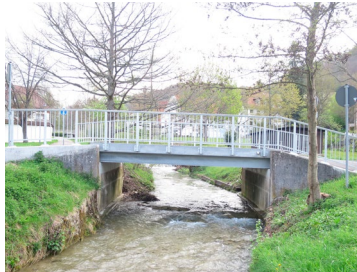
Ersatzneubau – fertig sanierte Brücke in Albstadt-Margrethausen.
