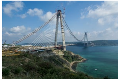
Die Brückenpylone sind extrem hohen Windlasten von 300 kg/m 2 ausgesetzt.
