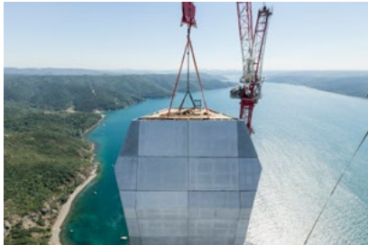
Das maximale Plattengewicht von 110 kg/m 2 war nur mit einer GRID-Bewehrung von solidian zu erreichen.
