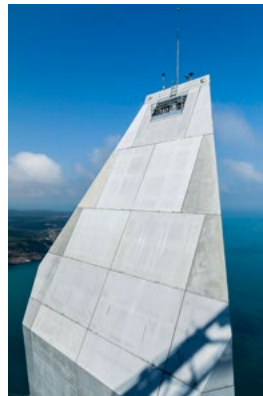
Stattliche 320 m hoch reichen die weltweit höchsten Brückenpylone der Bosphorus-Brücke in den Himmel.
